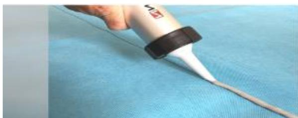
Para un acabado perfecto, se puede añadir un sellador de juntas para exterior (masilla de poliuretano monocomponente).
