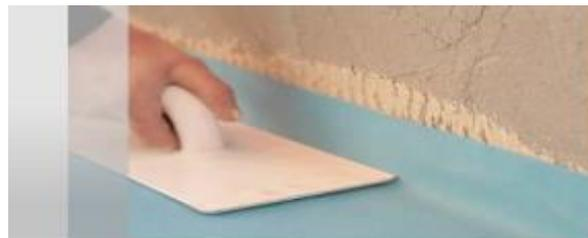
Se coloca la lámina DakuaStop sin que quede aire entre el mortero y la lámina.
