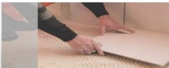
La lámina DakuaStop se cubre con mortero para fijar los azulejos, mármoles, cerámica, etc.
